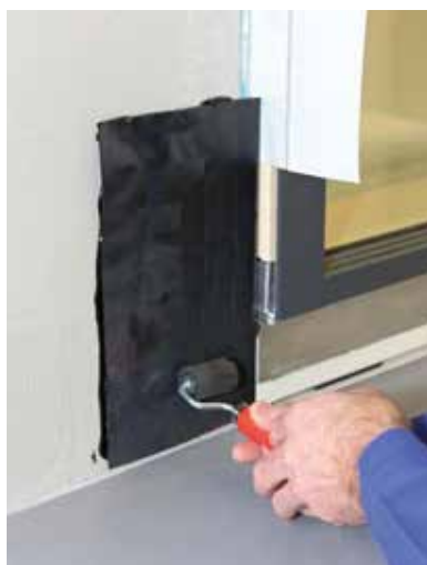
Dichtungsfolie mit Befestigungsblech für seitliche Schwellenanbindung mit Hartgummiroller an Baukörper kräftig andrücken. Wir empfehlen eine Verklebungsbreite am Baukörper von > 10 cm.
