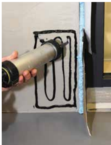
Dauerelastischen Dichtstoff Teroson auf Mauerwerk auftragen.
