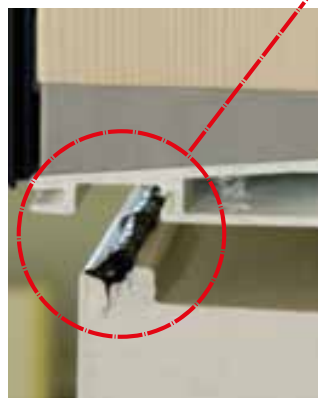
Dichtraupe vor Montage Unterbauprofil zu Bodenschwelle
