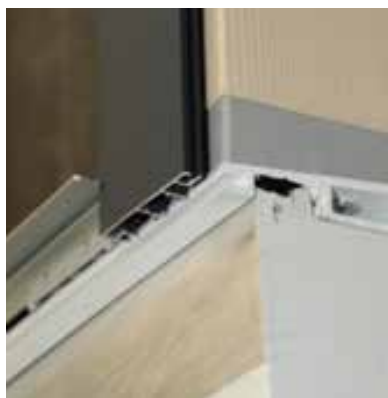
Montierte Schwelle mit abgedichteten Unterbauprofil
