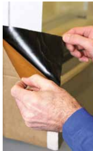
Schutzfolie von Dichtungsfolie mit Befestigungsblech 200 x 1,5 für seitliche Schwellenanbindung abziehen.
